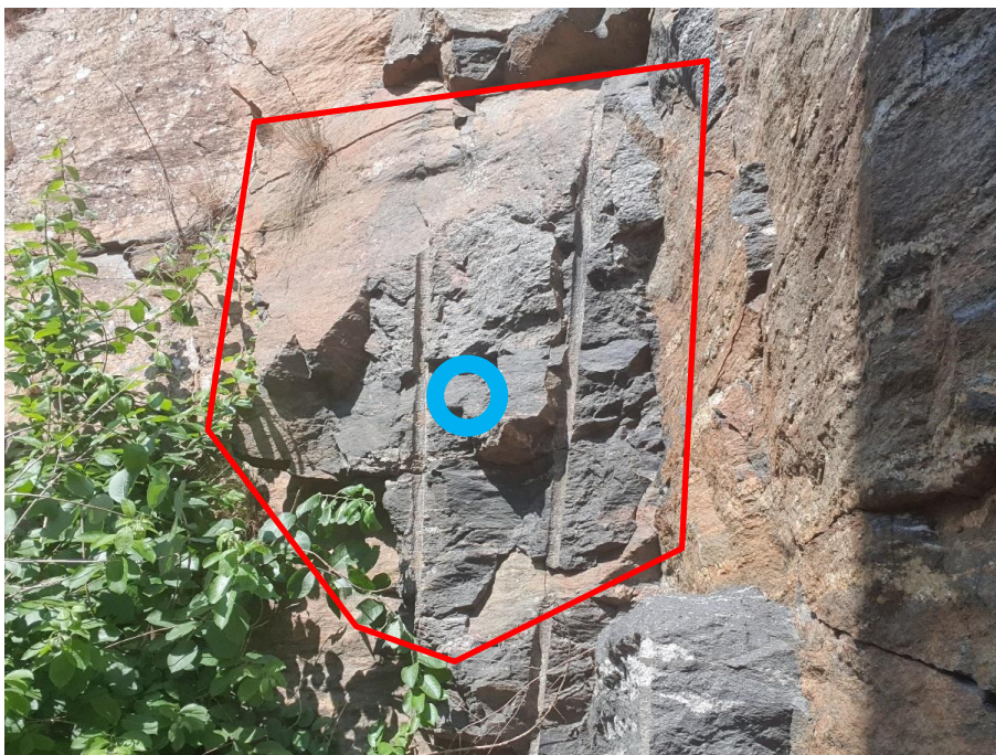
Figur 4.2. Block på medelbrant-brant glidplan bakom busken saknar bottenstöd (rött) samt föreslaget läge för bergbult L=2 m (blått).
